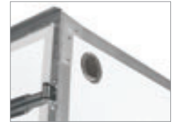
Be- und Entlüftung
